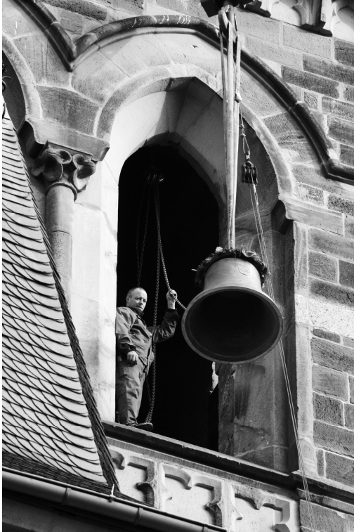
Abb. 122: Einbringen der neuen Glocken in in den sanierten Glockenstuhl am 7. Dezember 2009
